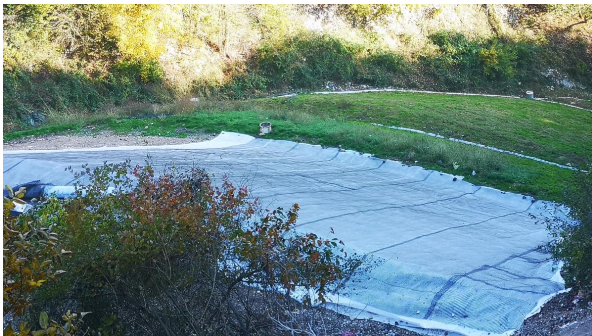
Plino propustni sloj prekrit in armiran. Priprava za končni sloj
