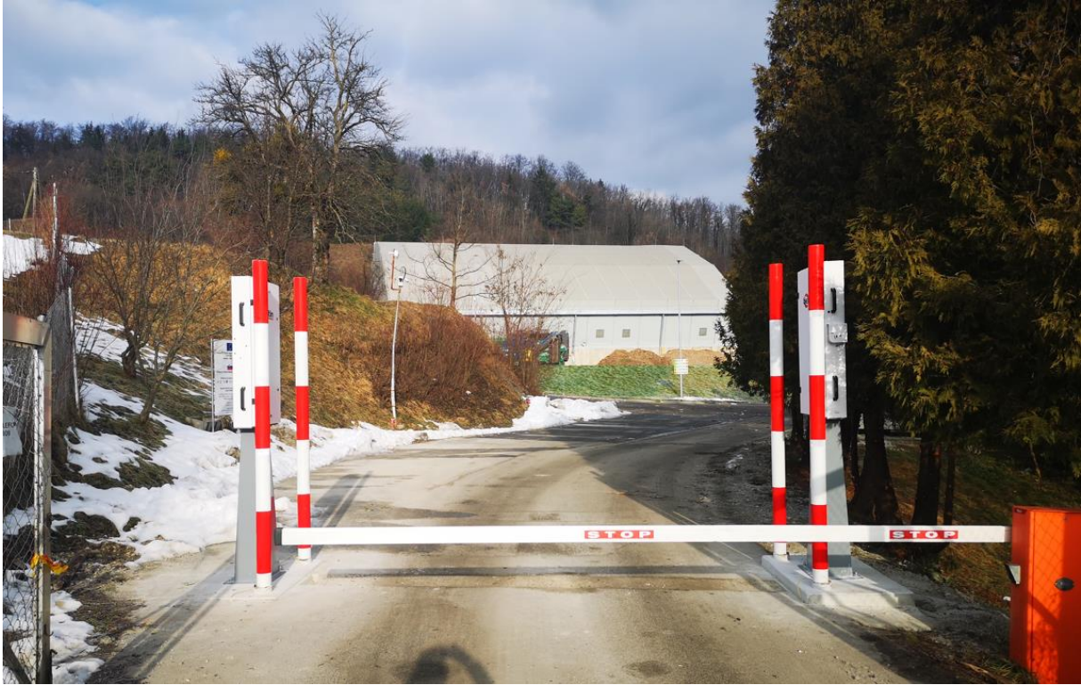
Portalni monitor je vgrajen na vhodu pred mostovno tehcnico
