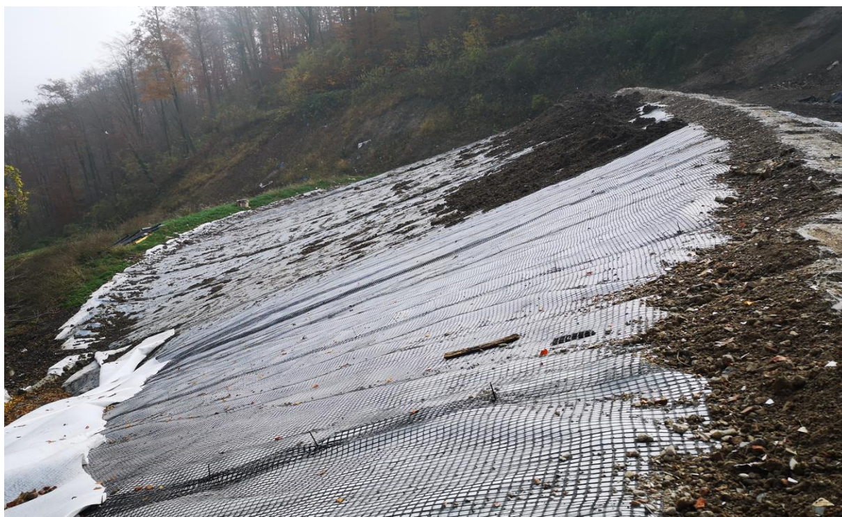
Plino propustni sloj prekrit in armiran. Priprava za končni sloj
