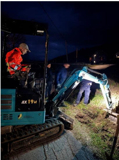
Slika 5: Izvajanje strojnih del pri odpravi okvare na vodovodu
