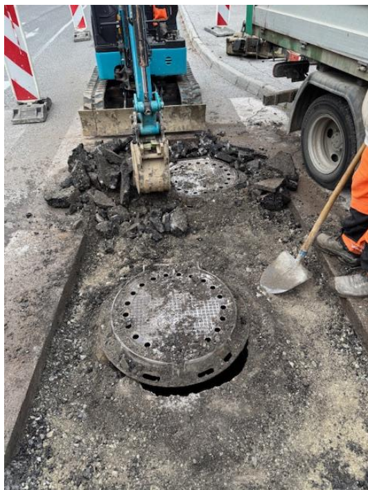
Slika 6: Menjava kanalizacijskega pokrova
