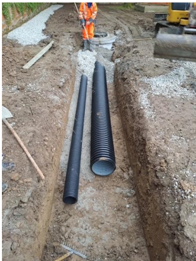
Slika 7: Izvajanje kanalizacijskih del
