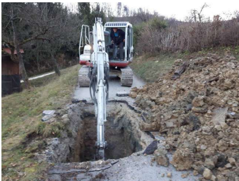
Slika 4: Izvajanje strojnih del pri odpravi okvare na vodovodu
