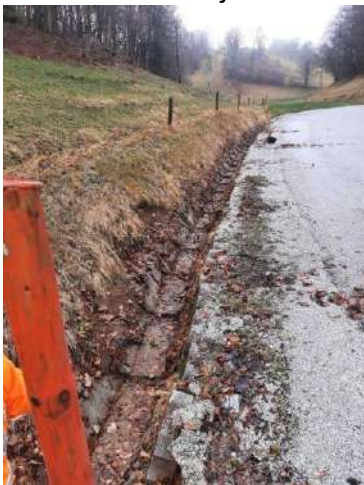
Slika 22: Čiščenje kanalet na Kalu
