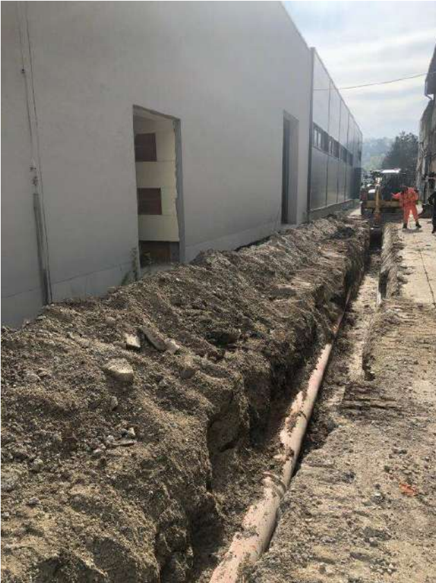
Slika 6, 7: Izvedba sekundarnega voda preko dvorišča Rujz Design in izdelava priključka v Bobnu
