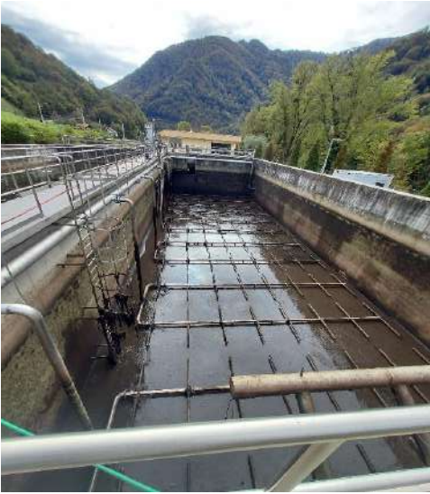
Slika 10: okvara in menjava prezračevalcev v SBR1
