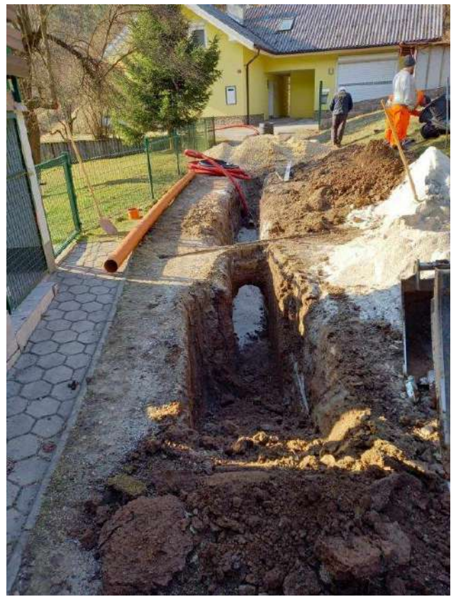
Slika 6, 7: Izvedba sekundarnega voda preko dvorišča Rujz Design in izdelava priključka v Bobnu
