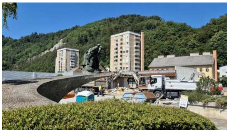
Fotografija: Podiranje starega poslovnega kompleksa in urejanje okolice
